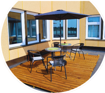
Terrassgolv byggt av ReKi-gruppen för Varppis takterrass.
