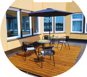
ReKi-ryhmän rakentama terassilaudoituus Varpin kattoterassille
